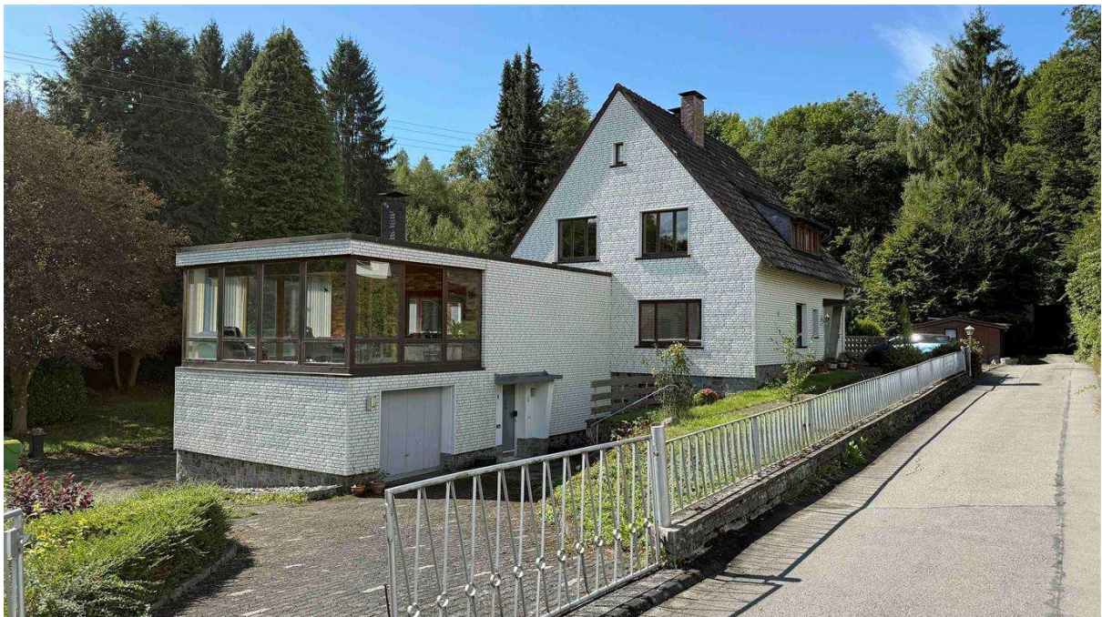
Ostgiebel mit Wintergarten und Garage
