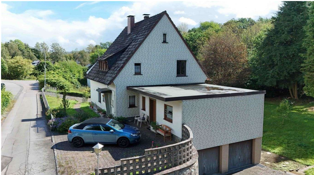
Westgiebel mit Doppelgarage
