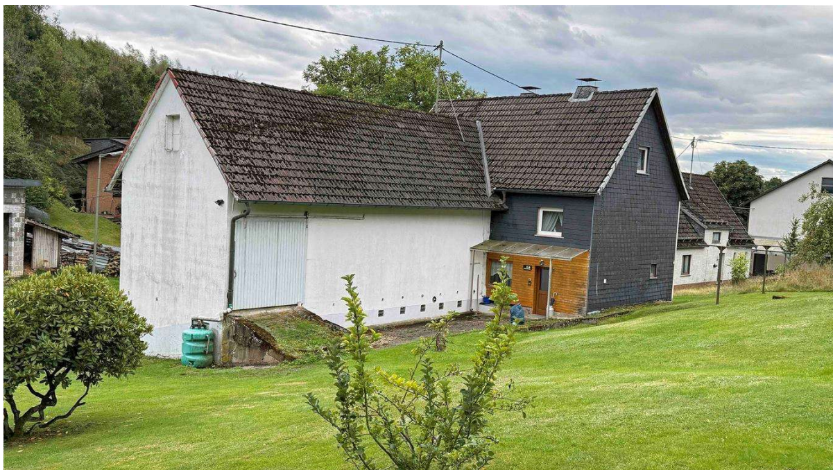
Rückseite mit überdachtem Nebeneingang zur Küche
