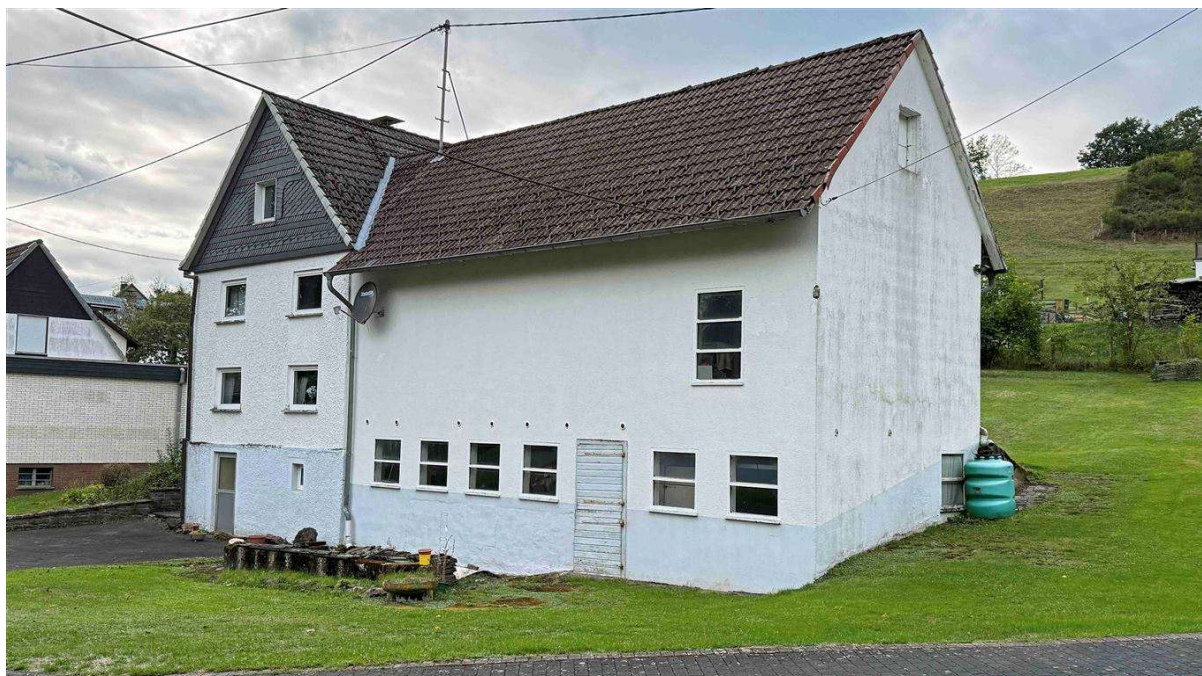
Nebengebäude 15 x 6 m. Erdgeschoss: Stall; Obergeschoss: Scheune
