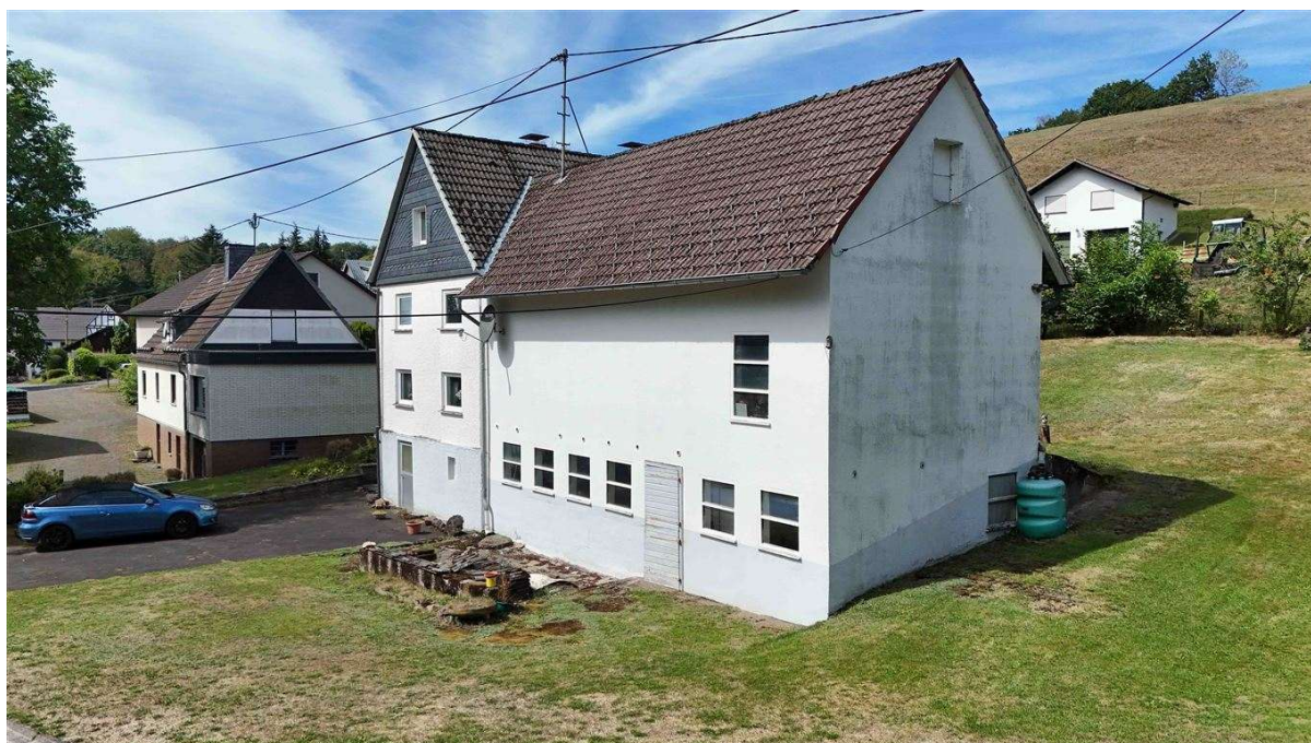
massives Nebengebäude als Stall/Scheune
