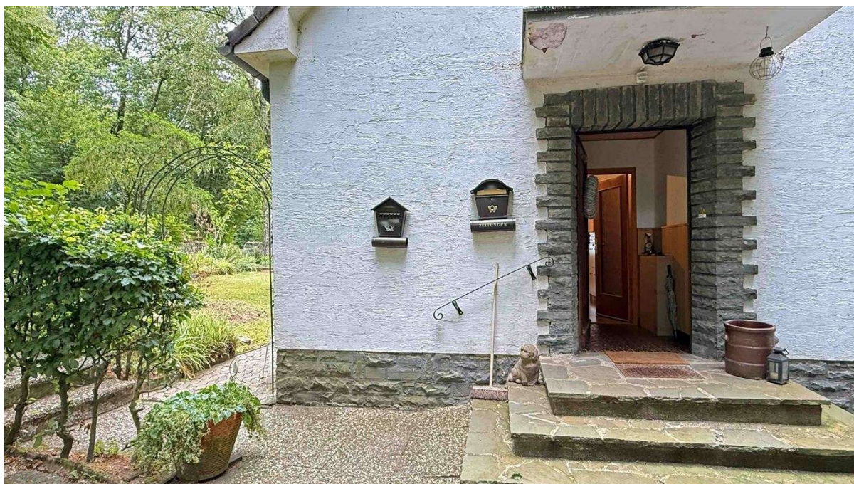
Eingang zur Wohnung im Erdgeschoss (78 m 2 )
