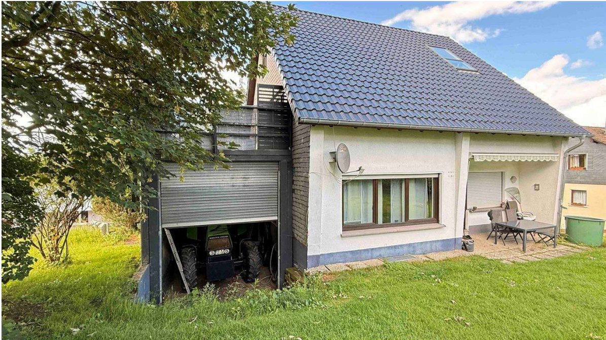
Hausrückseite mit Rasenfläche, Terrasse und...
