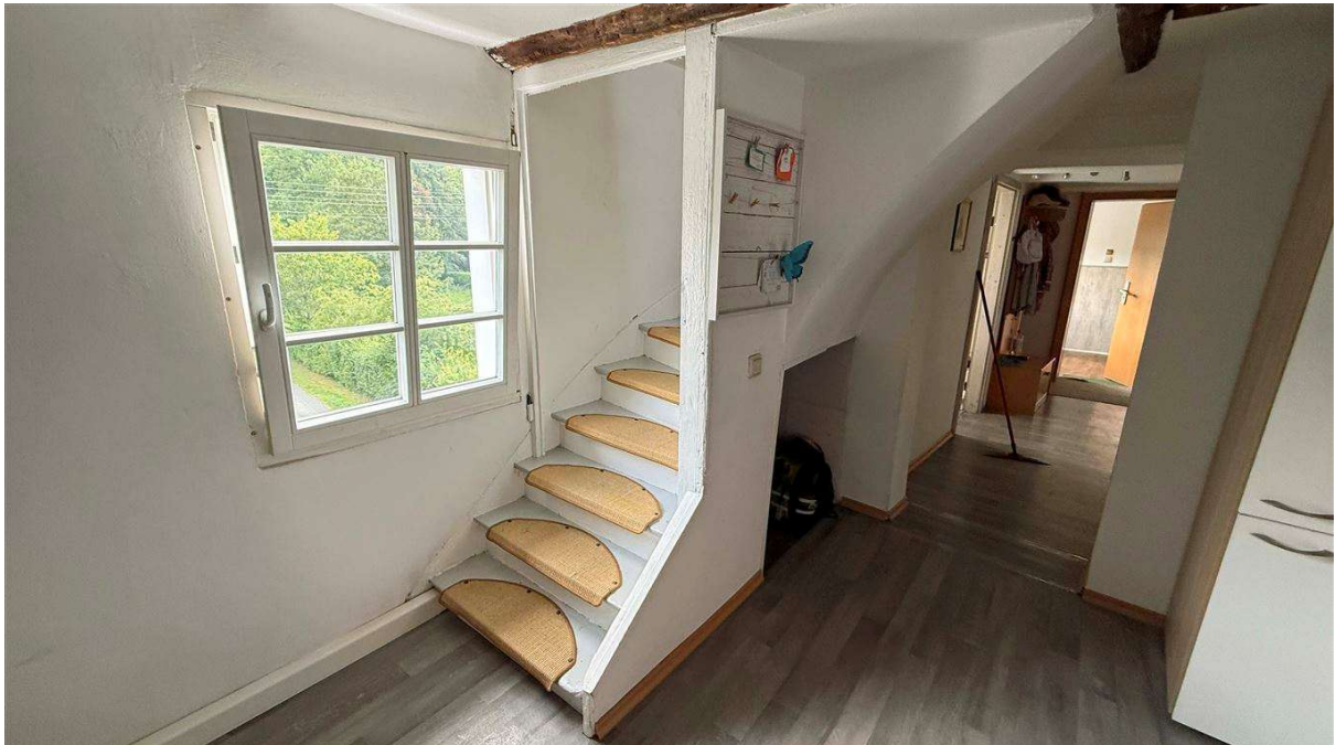
Wohnung 95 m 2 : Treppenaufgang zum Dachgeschoss
