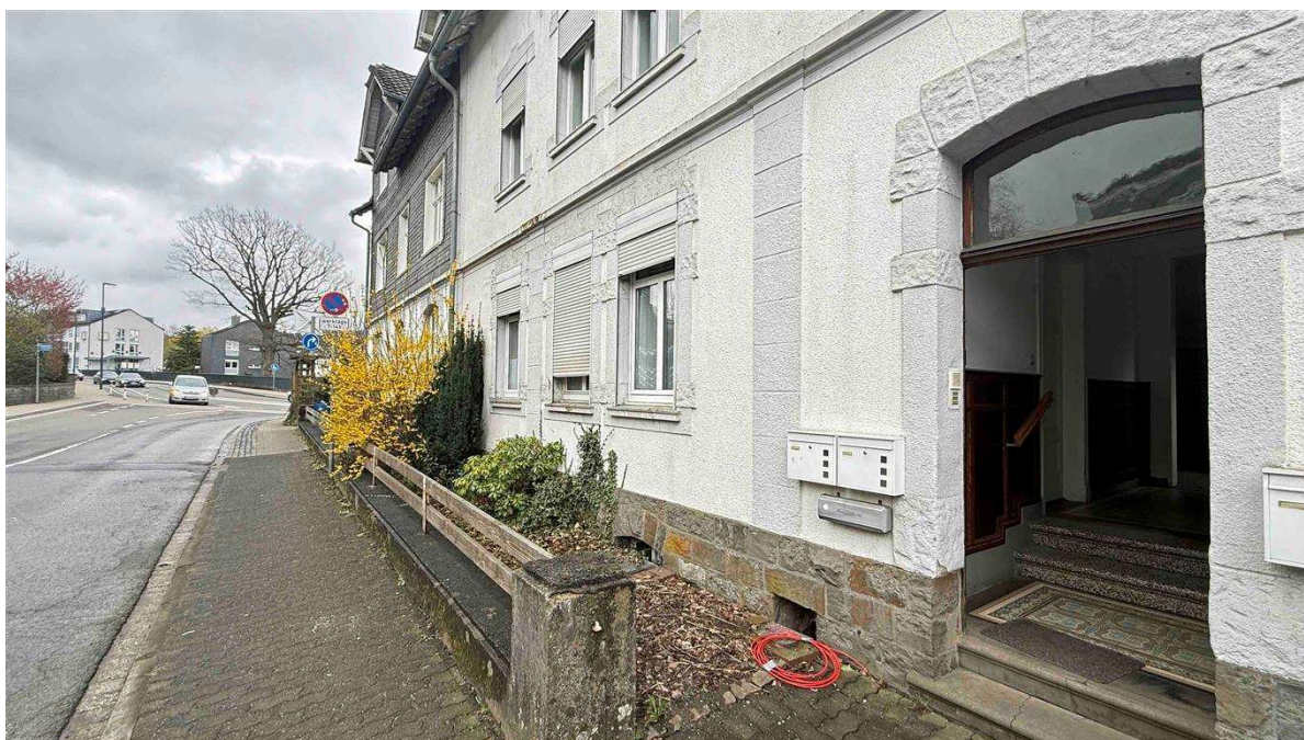
Glasfaser-Internanschluss bereits zum Haus verlegt
