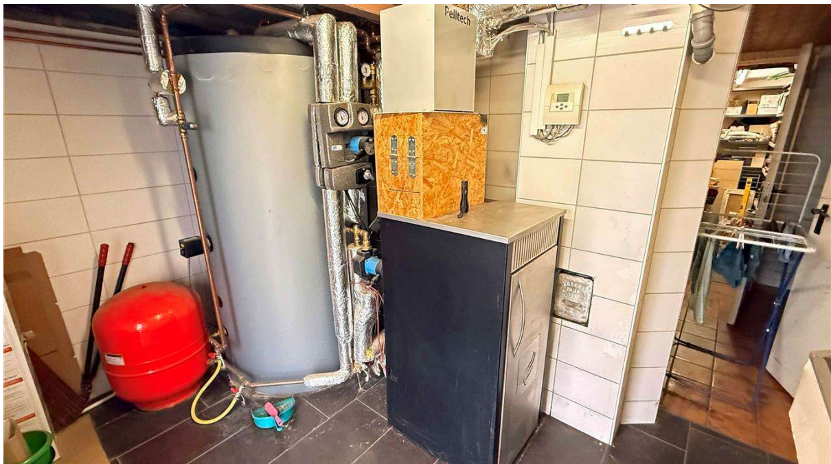
...und 800 L Pufferspeicher mit Elektro-Heizstab
