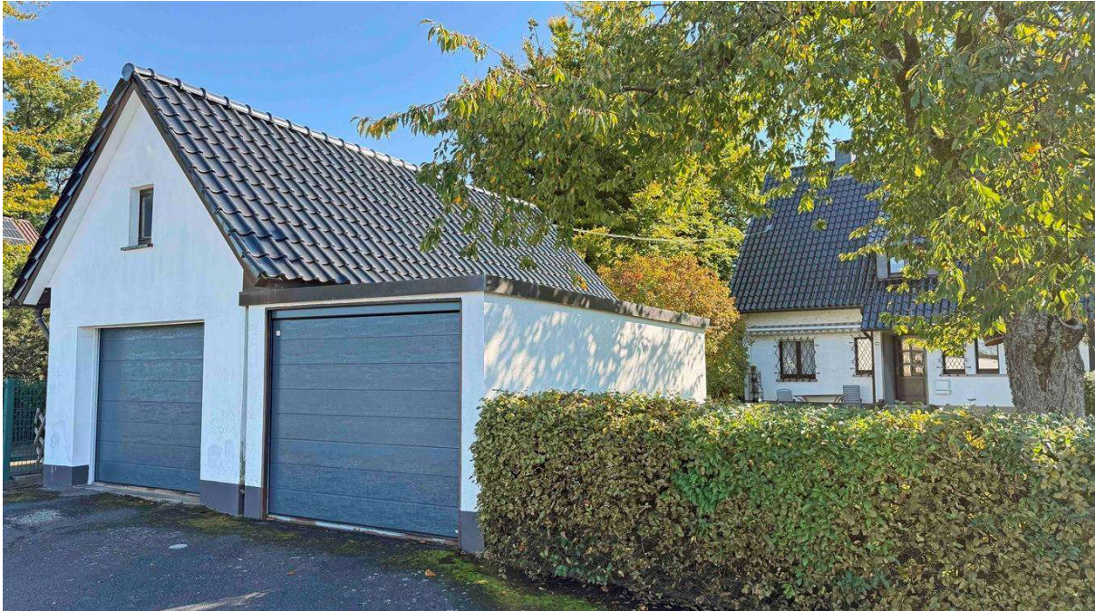
2 massive Garagen. Die Dächer wurden 1999 erneuert
