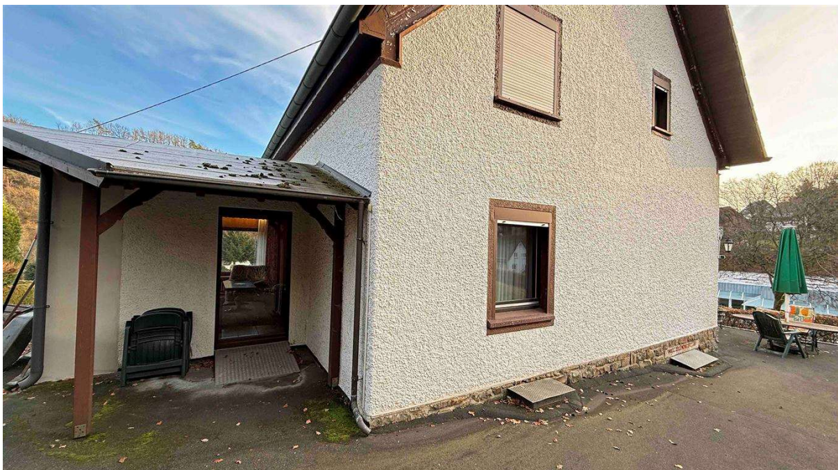
geteerte Zufahrt bis zum barrierefreien 2. Eingang
