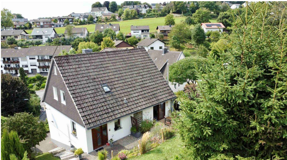
Hausrückseite mit Haupteingang
