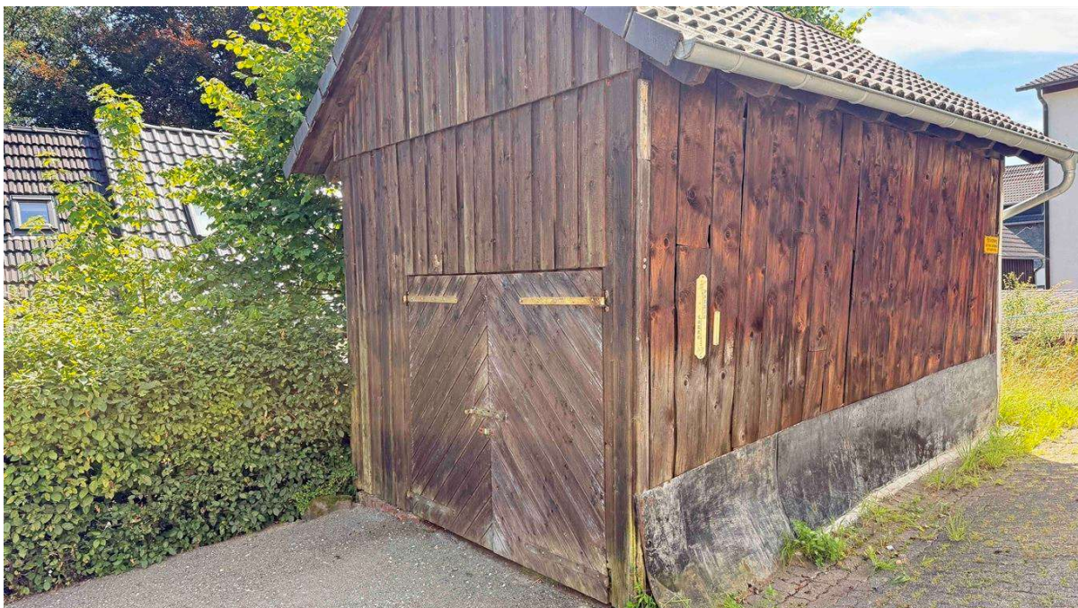
...der kleinen Scheune (3 x 5,50 m)
