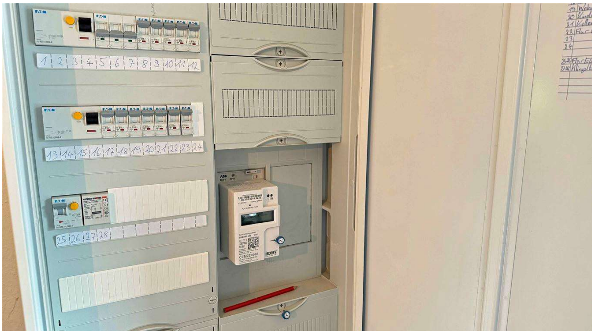
Elektroinstallationen alle neu
