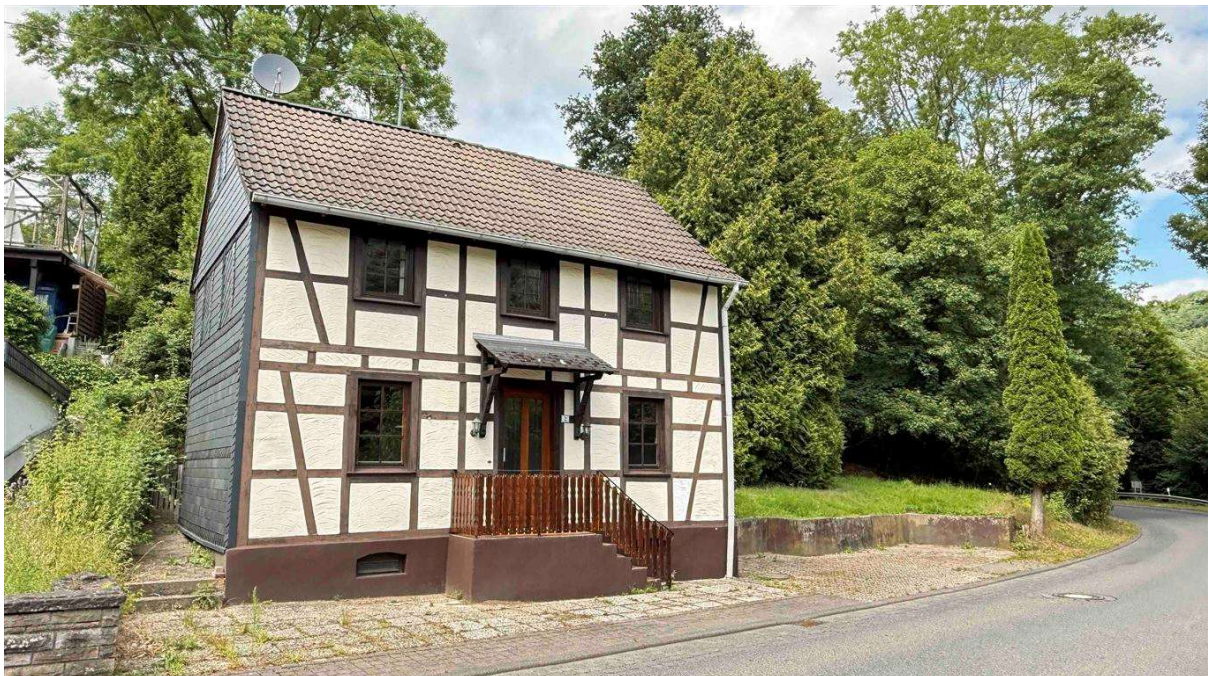
98 m 2 Wohnfläche, kompl. Renoviert / sofort einzugsbereit
