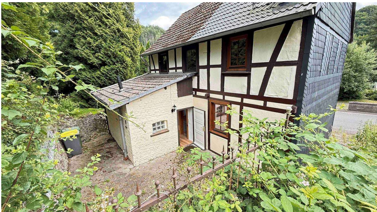
Rückseite mit Anbau (Küche/ WC) und Innenhof
