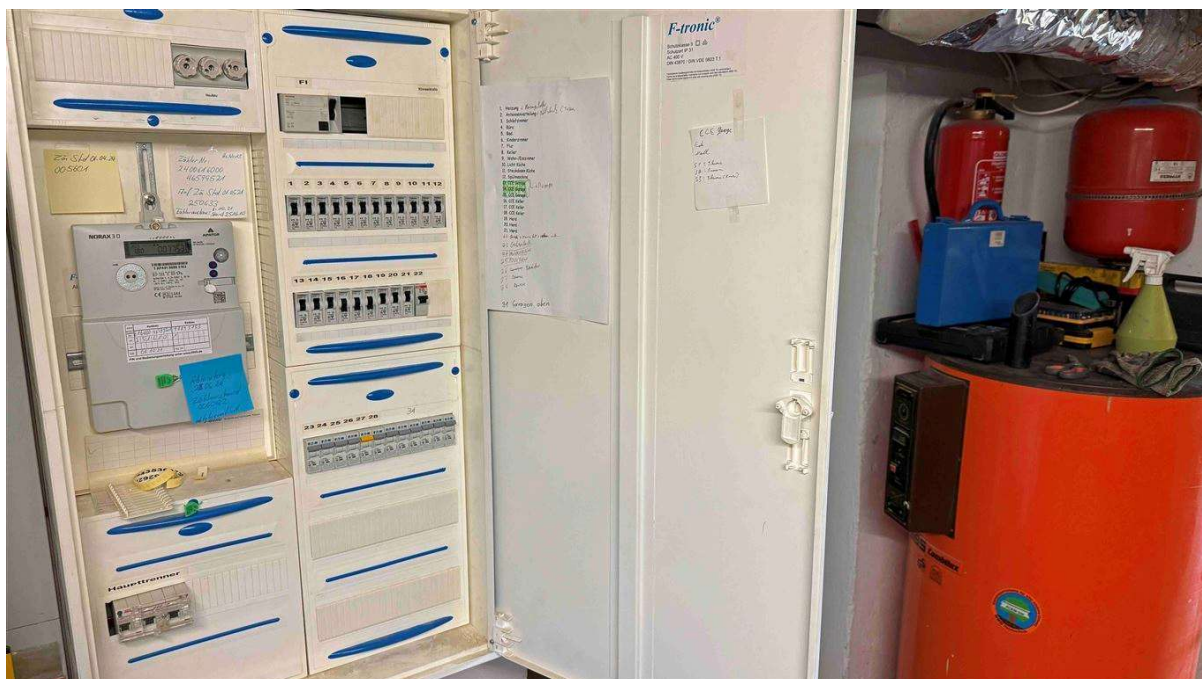
Elektrik modernisiert und für beide Häuser getrennt
