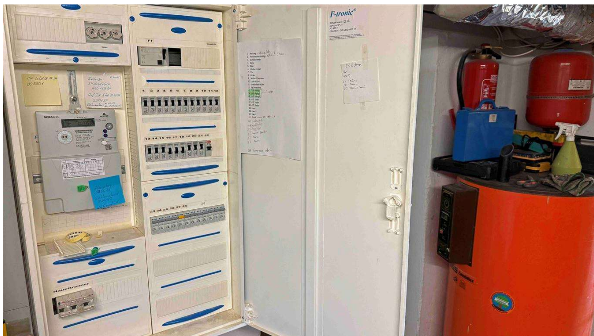
Elektrik modernisiert und für beide Häuser getrennt
