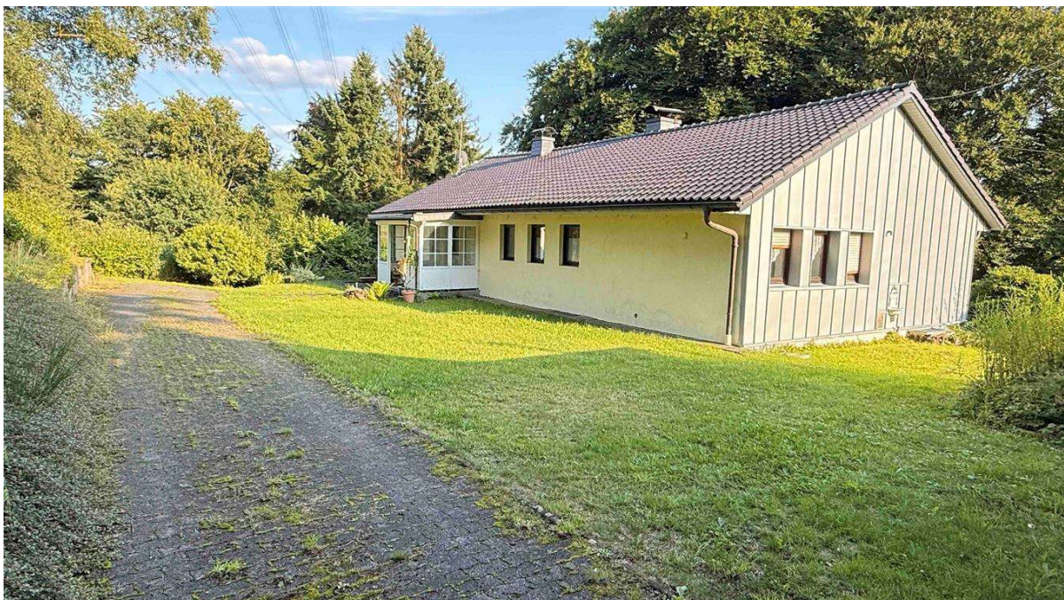
Dach (2004) und Fassade (2018) wurden erneuert
