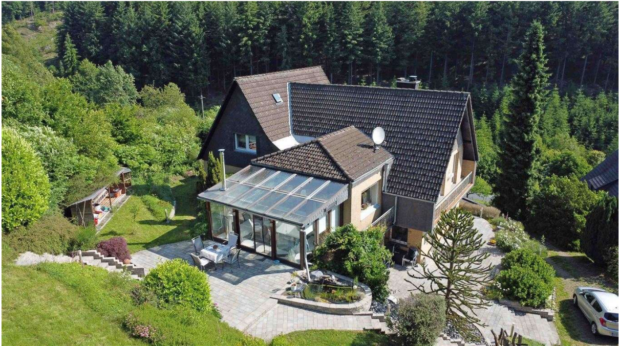
Süd-/Westseite komplett mit Terrassen angelegt
