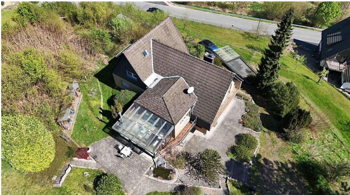
Süd-/Westseite komplett mit Terrassen angelegt
