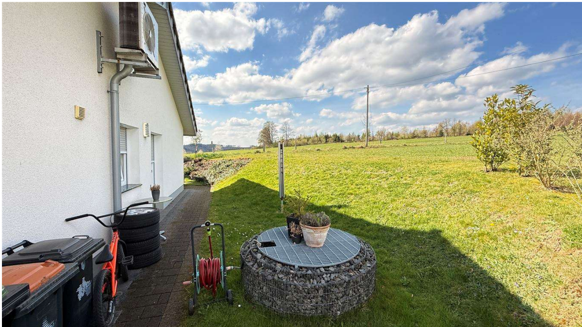
FB-Heizung mit Wärmepumpe, eigener Brunnen
