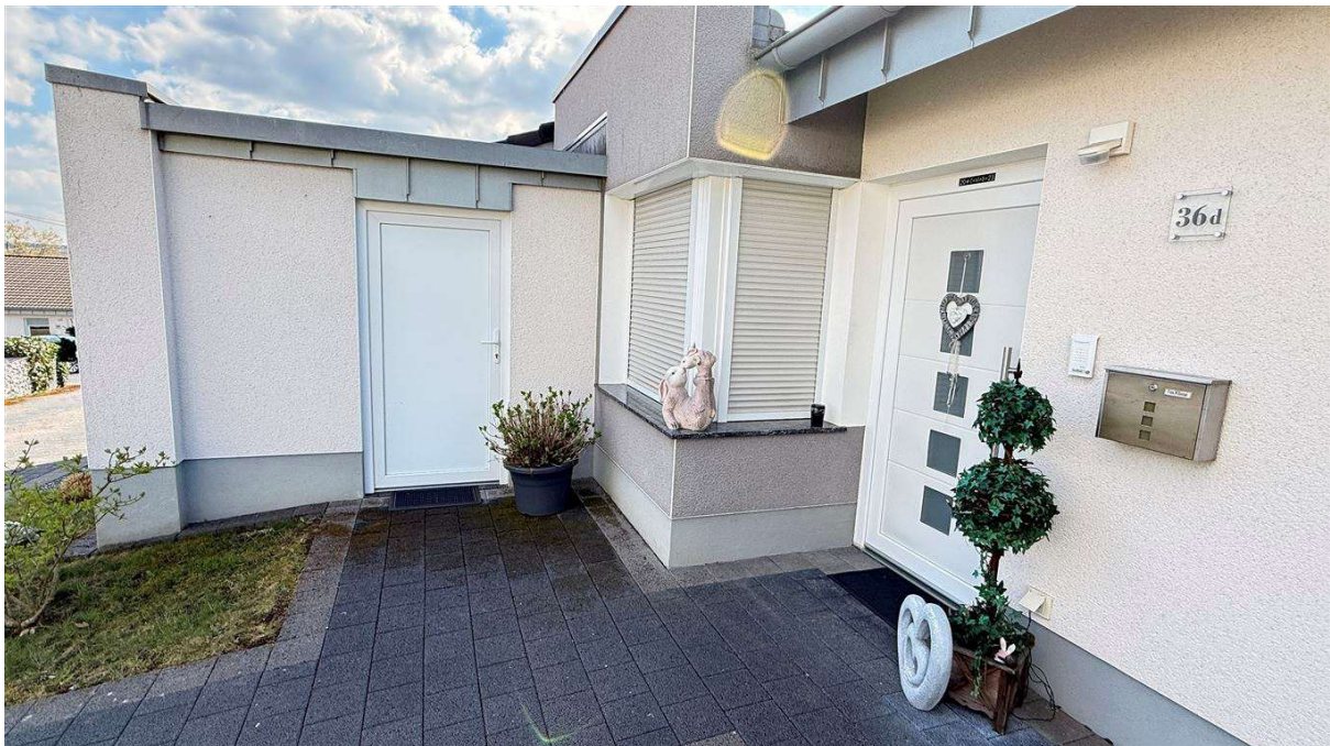
angebauter Abstellraum (Tür links), als Kellerersatz
