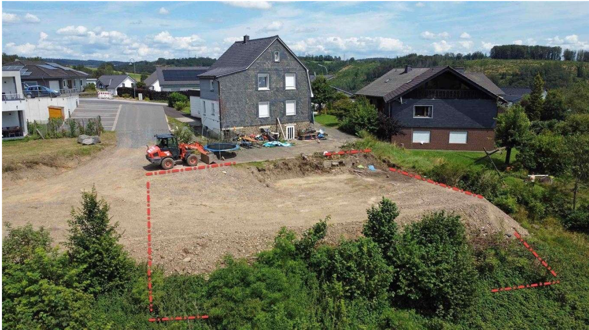
Ansicht vorhandenes Grundstück (Süd-West)
