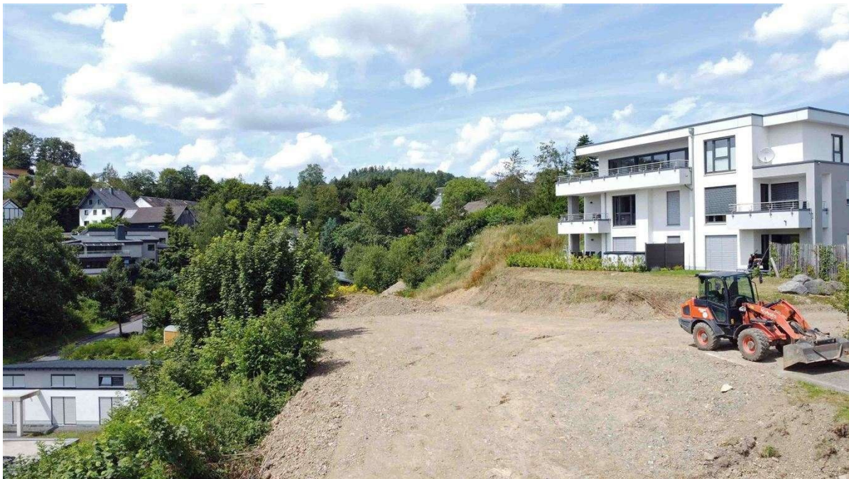
Seitenansicht Grundstück (Süd-Ost)
