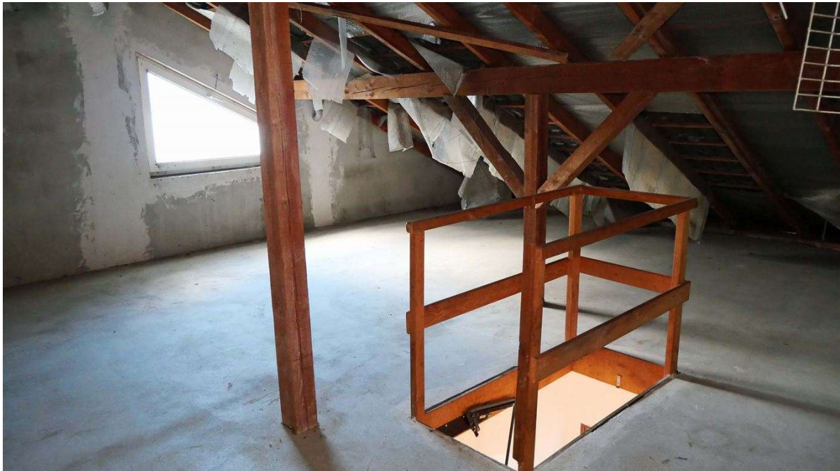
Ausbaureserve/Abstellraum unter dem Dach
