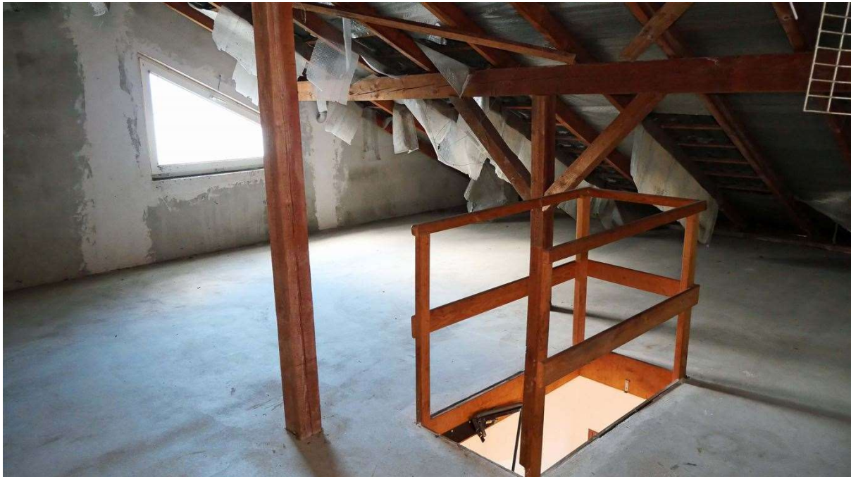
Ausbaureserve/Abstellraum unter dem Dach
