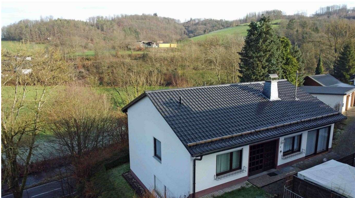
Das Dach wurde 2019 modernisiert und gedämmt
