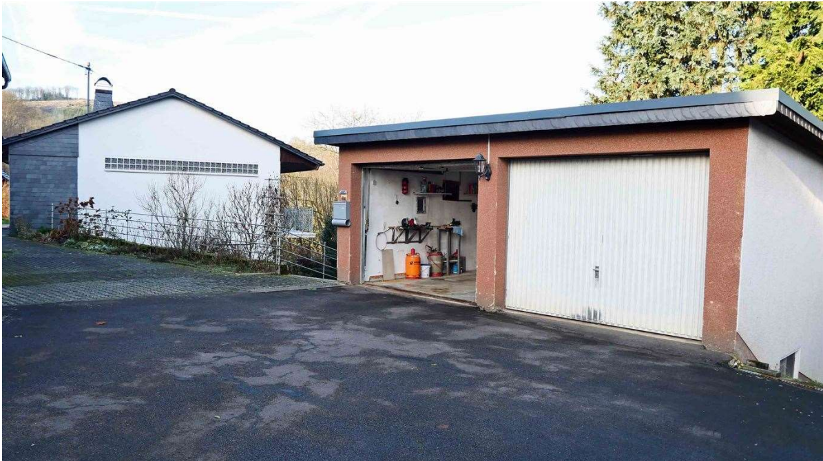
Nebengebäude mit 2 Garagen und Werkstatt darunter
