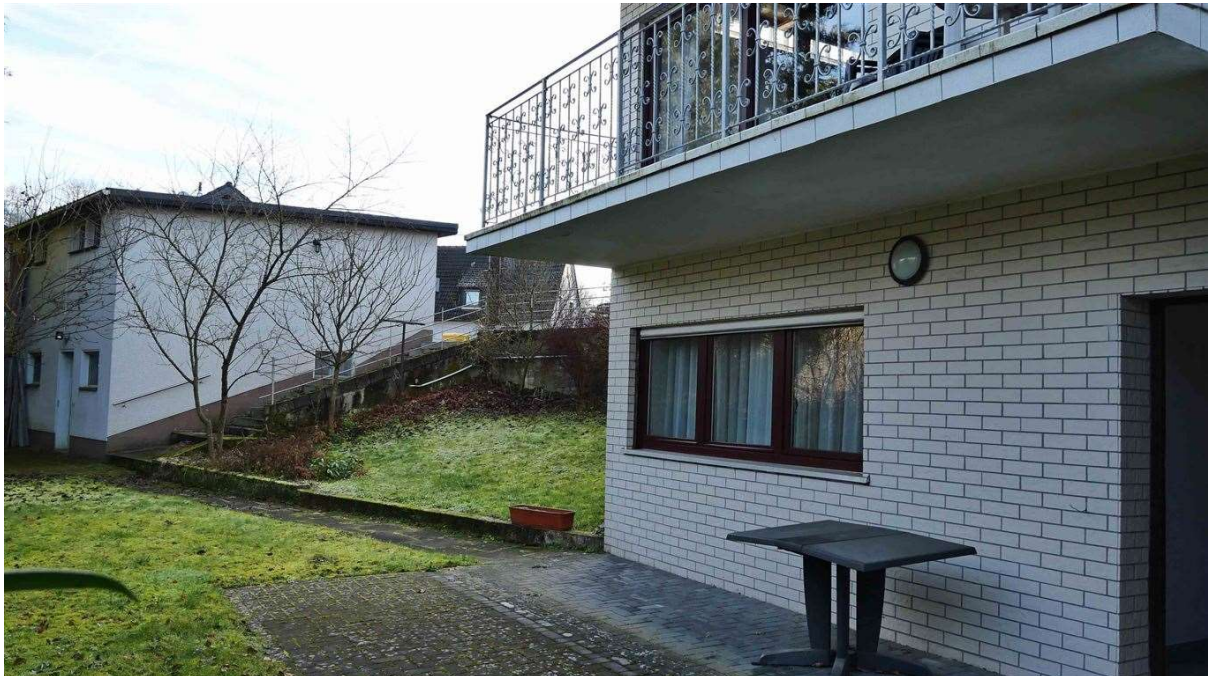
Blick vom Wohnhaus zum Garten und Nebengebäude
