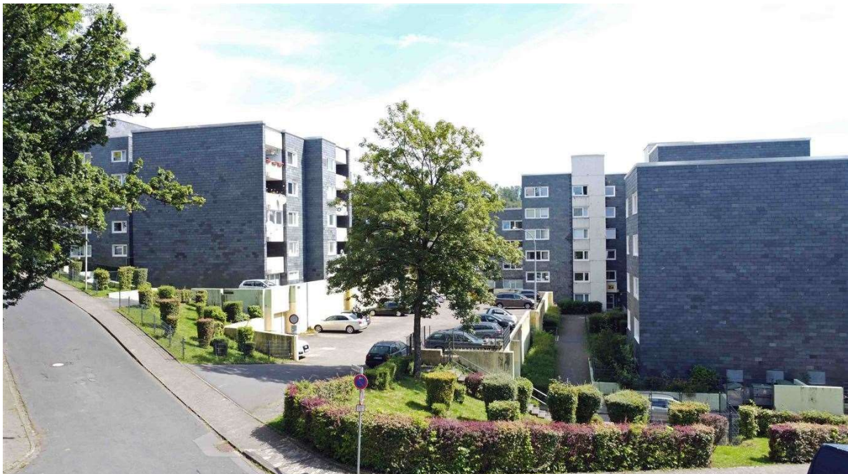
Parkplätze und Garagen direkt vor der Haustür
