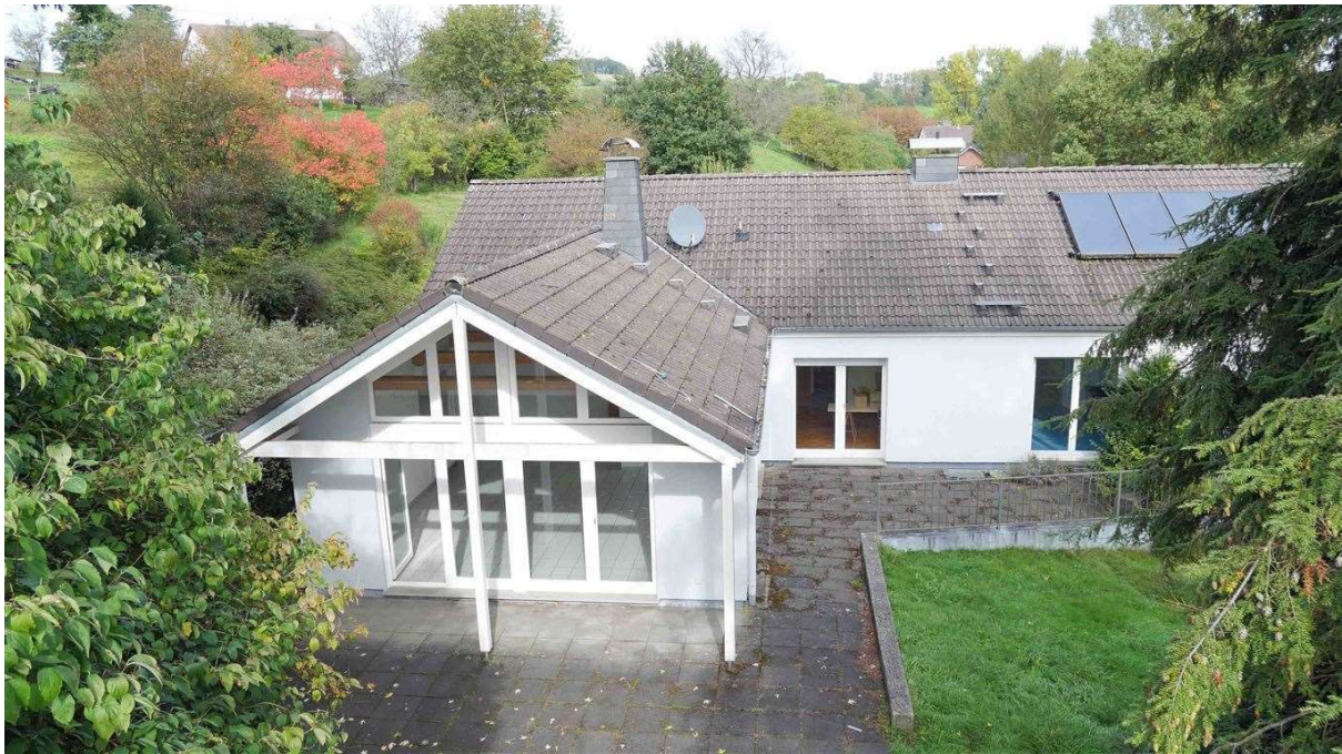
Rück-/Südseite mit Terrasse und Solaranlage
