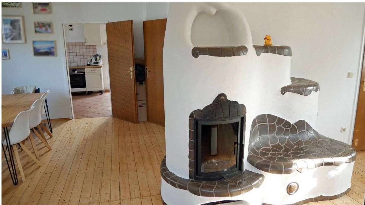
Kachelofen ist an die Zentralheizung angeschlossen
