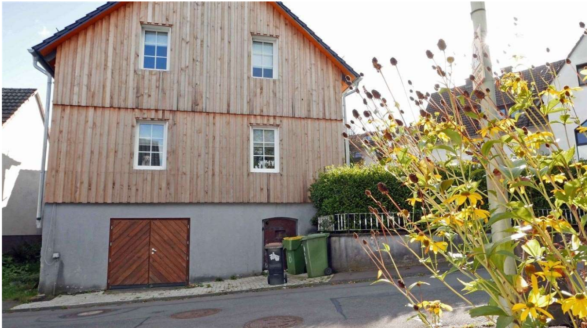
Ebenerdig zugänglicher Keller.
