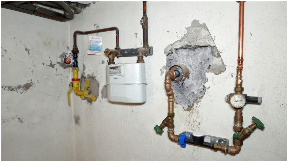
neuerlegte Installationen für Erdgas und Wasser
