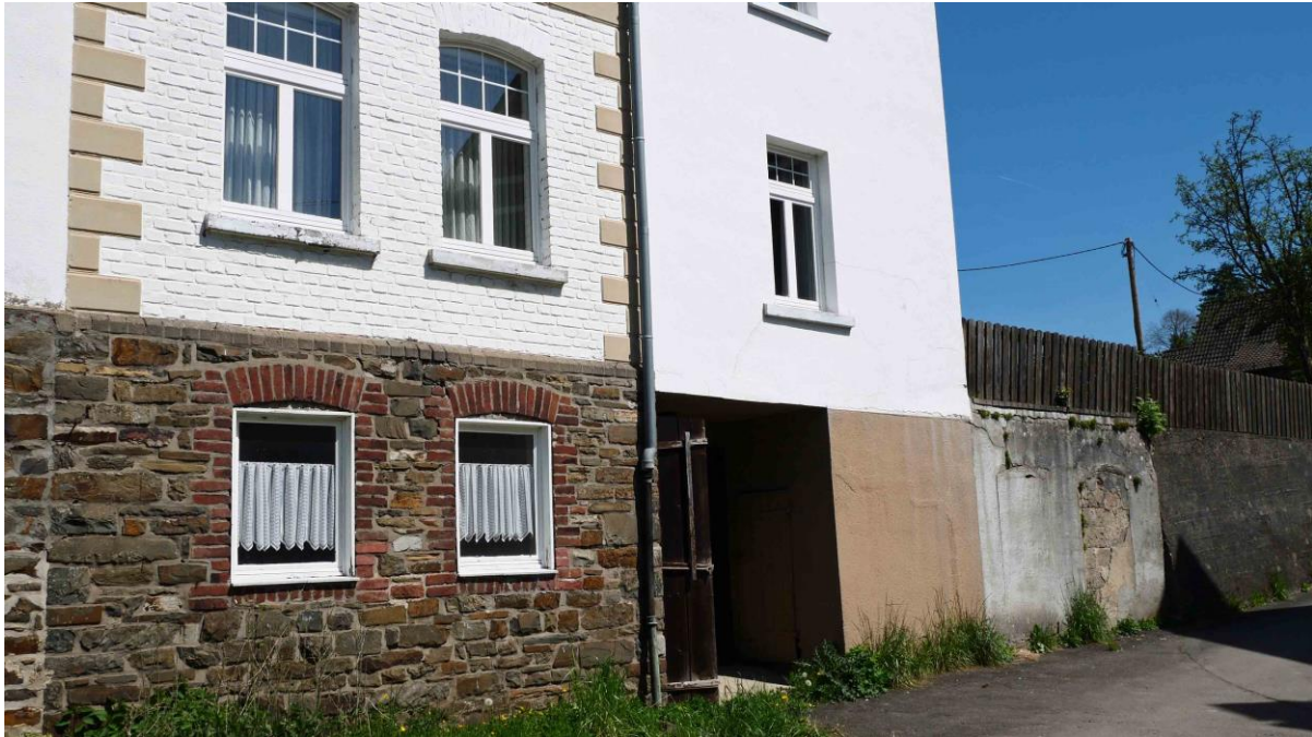
Keller mit ebenerdig begeh-/anfahrbarem Eingang...
