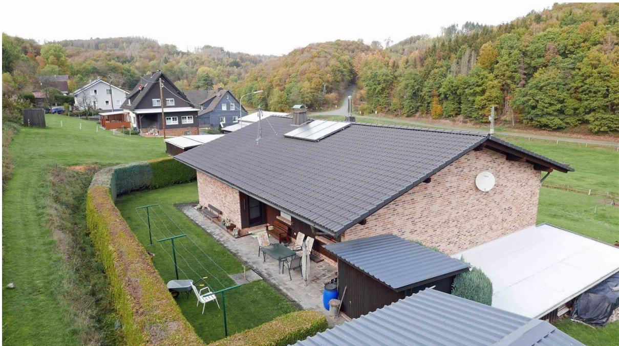
Hausrückseite mit Terrasse. Nur wenige Nachbarn
