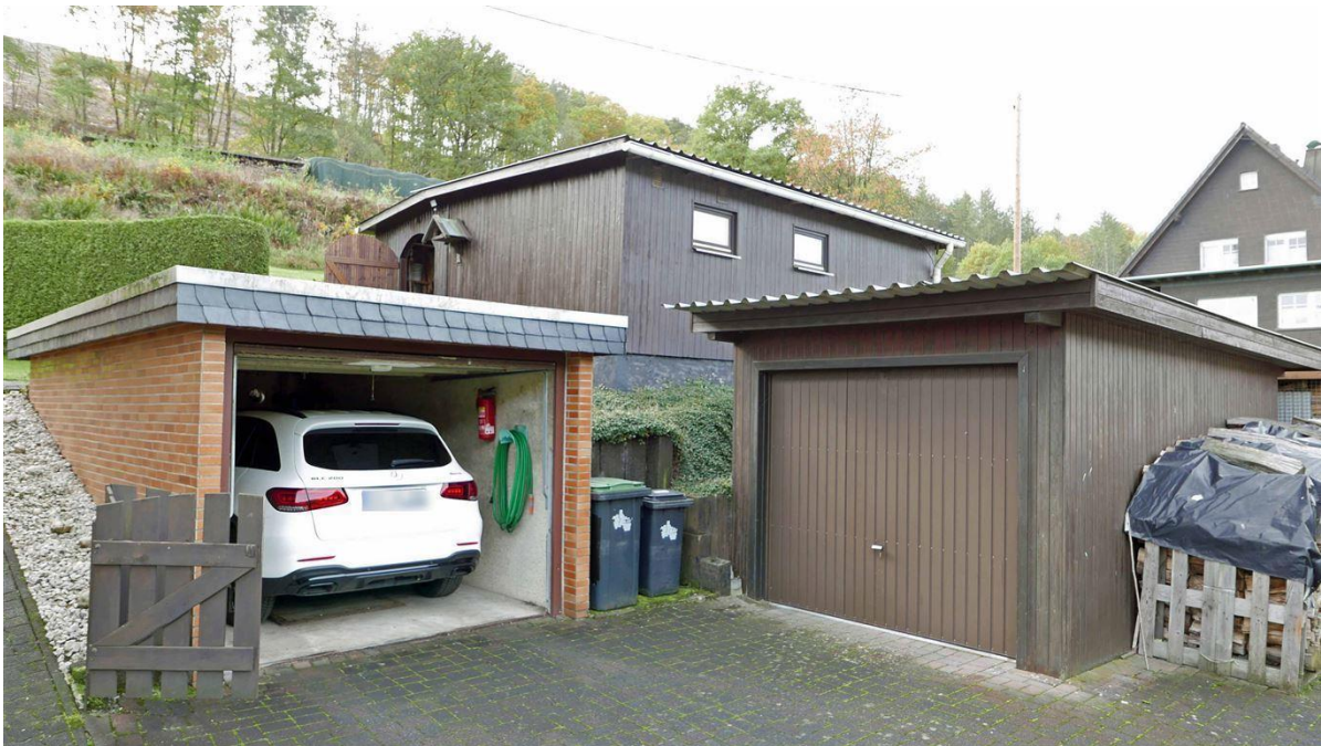
Vorderbereich mit zwei Garagen und Werkstatt
