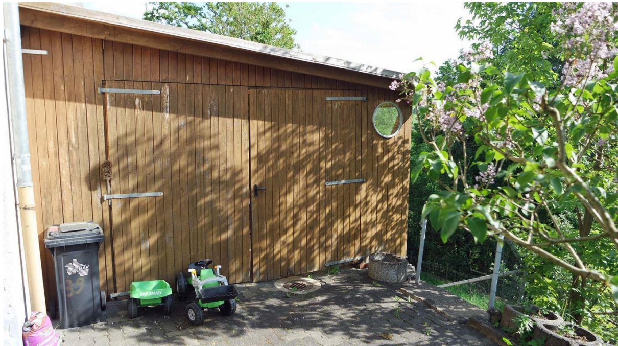
Holzschuppen an der Hausrückseite
