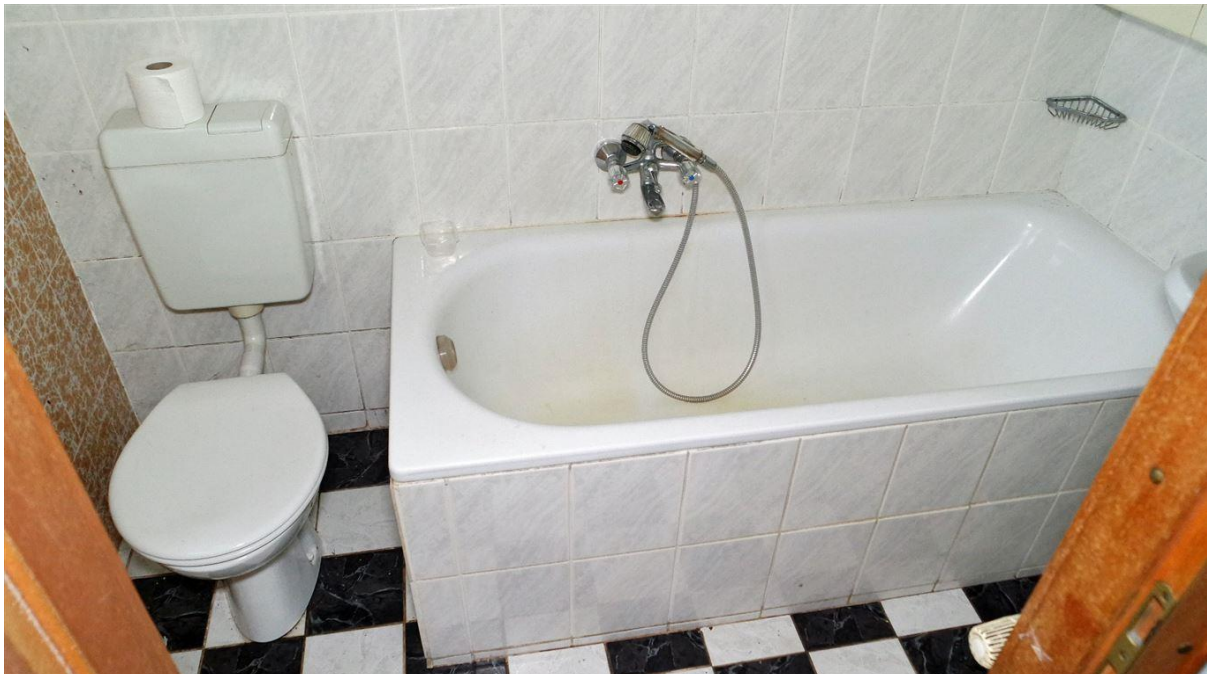
Badezimmer. Im Keller befindet sich ein drittes WC
