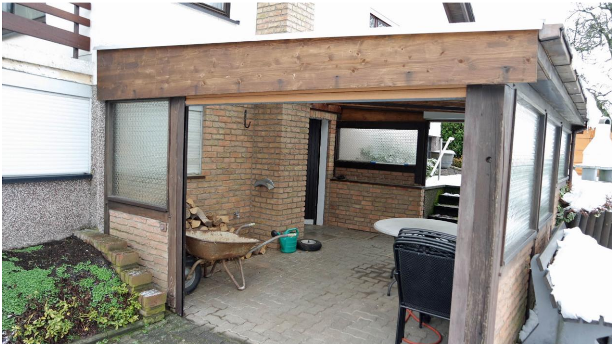
überdachter, ebenerdiger Zugang/Zufahrt zum Keller
